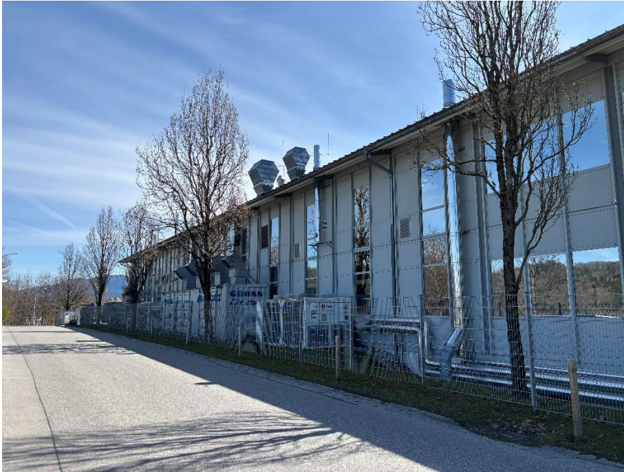
Abb. 26: Ansicht von Westen – Baumreihe entlang Breslauer Straße im Norden (Foto April 2025 Jocham Kessler Kellhuber GmbH)
