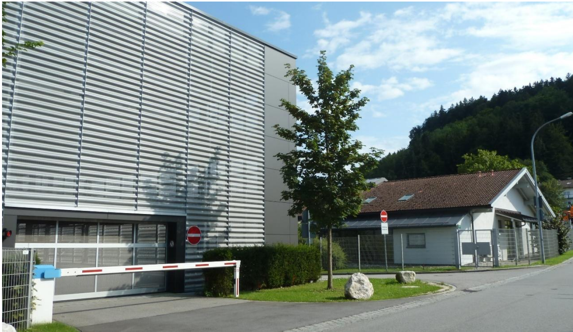
Abb. 4: Ansicht von Norden – betriebliches Parkhaus und Bürogebäude entlang der Breslauer Straße (Foto August 2024 Jocham Kessler Kellhuber GmbH)
