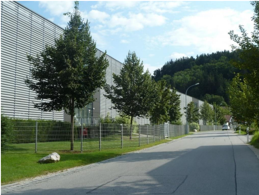
Abb. 23: Ansicht von Norden – Baumreihe entlang Breslauer Straße im Westen (Foto August 2024 Jocham Kessler Kellhuber GmbH)
