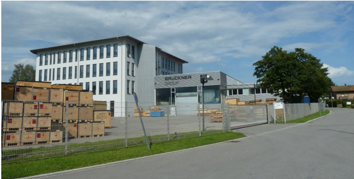
Abb. 2: Ansicht von Westen – Büro und Werkstatt entlang der Königsberger Straße (Foto August 2024 Jocham Kessler Kellhuber GmbH)
