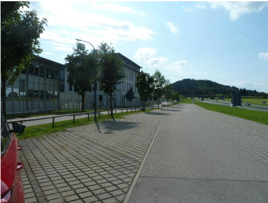
Abb. 25: Ansicht von Osten – Baumreihe entlang Breslauer Straße im Norden und entlang Betriebsparkplatz (Foto August 2024 Jocham Kessler Kellhuber GmbH)
