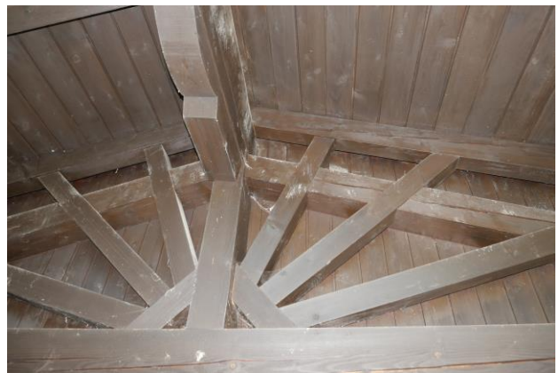
Abbildung 18: Holzkonstruktion oberhalb des Garagentors.
