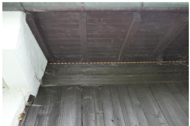
Abbildung 12: Übergänge Dachkonstruktion zu den Außenmauern bzw. die Holzverschalung wiesen keine für Fledermäuse nutzbaren Ausbrüche oder Spalten auf.
