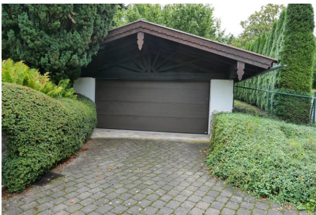
Abbildung 17: Einfahrt zur Garage.
