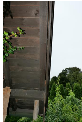
Abbildung 16: Spaltenquartier hinter den Ortgangbretter.
