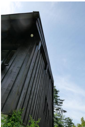
Abbildung 13: Geschlossene Holzverkleidung.
