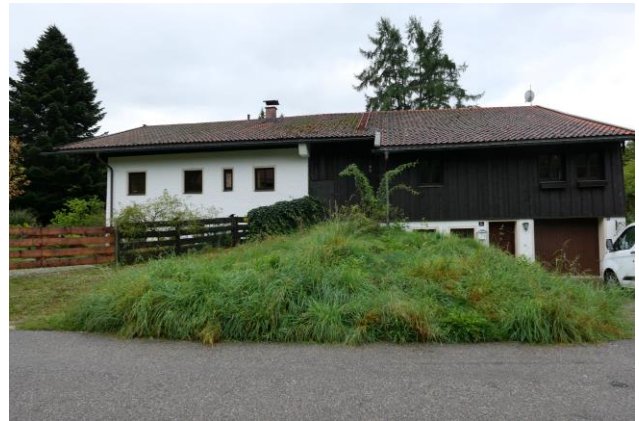
Abbildung 4: Nordansicht Gebäude Gerhartsreiter Straße 2 / 2a.
