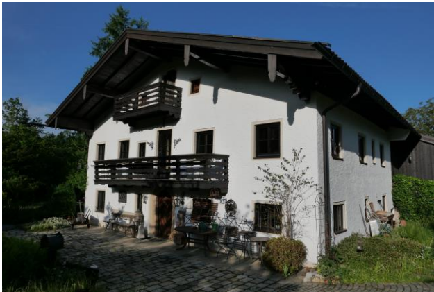
Abbildung 3: Ostansicht Gebäude Gerhartsreiter Straße 2.
