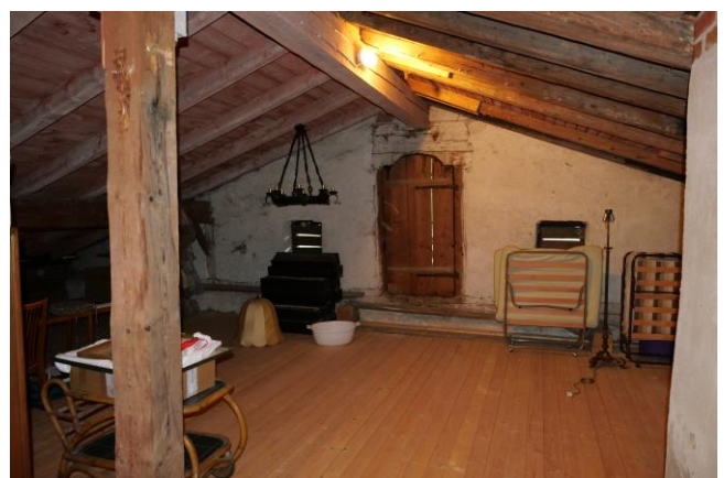
Abbildung 20: Übersicht des Dachbodens.
