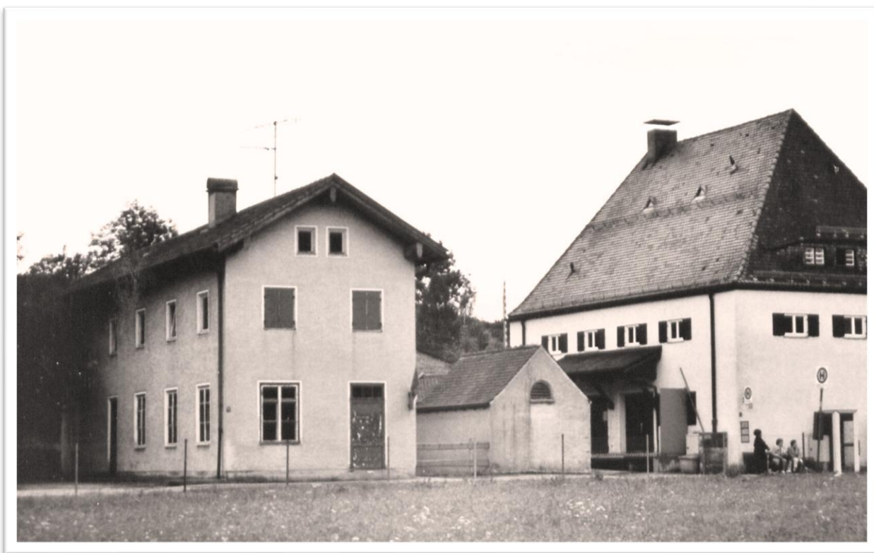
Historische Aufnahme vom Weinmüllerhaus und der „Alten Post“
