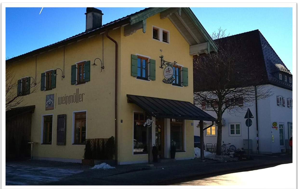
Weinmüllerhaus und „Alte Post“ nach der Sanierung
