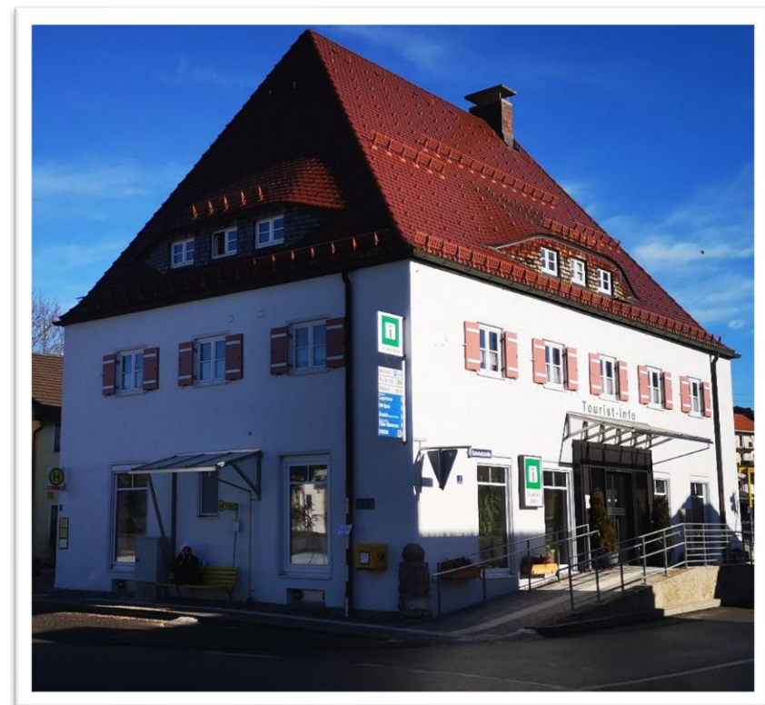
Die „Alte Post“ nach der Sanierung - heute Tourist-Info
