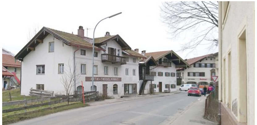
Die Einmündung zur Hauptstraße hat repräsentativen Ortseingangscharakter. Eine Sanierung der Oberflächen und Gebäude erscheint notwendig.
