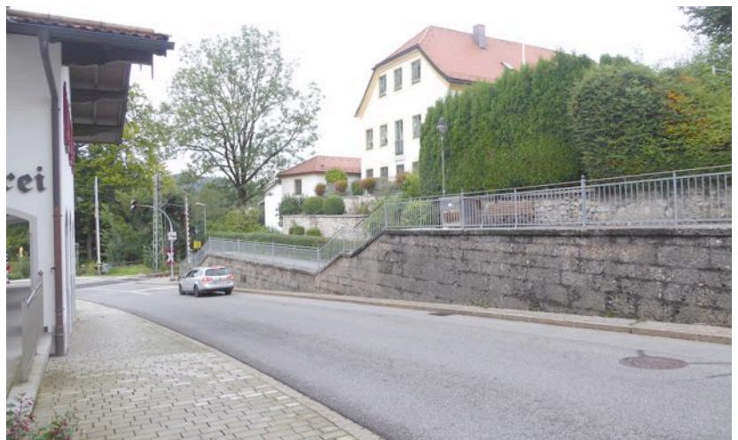
Blick zum Bahnübergang: Rechts im Bild die denkmalgeschützte Pfarr-Ökonomie mit Kooperatorhaus.
