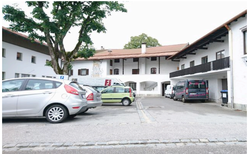
Der hofartige Vorbereich des Festsaaes (links) wird als Parkplatz genutzt. Im Hintergrund die Ostfassade des leerstehenden Gasthof Neue Post mit angeschlossenem Nebengebäude (rechts)
